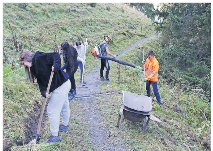
Ausbessern des Weges entlang des Stausees.
